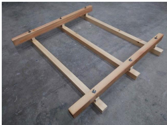
a) 野縁受け・野縁の仮組み
