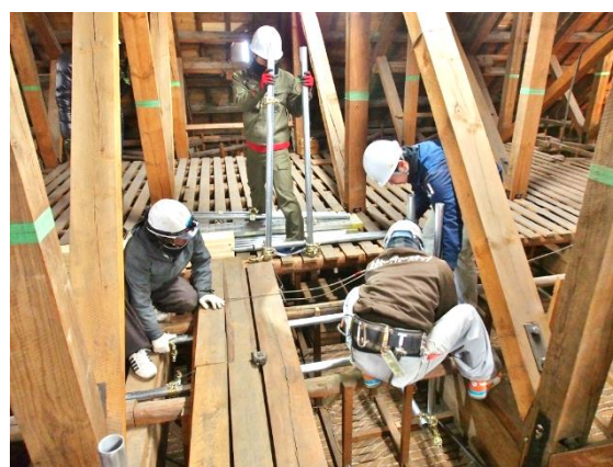
b) 足場の架設の様子 (U 字型に組んだ単管をフトコロに差し込んで締結)
