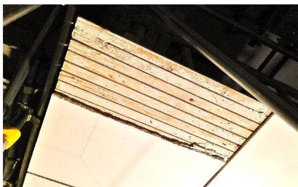
b) 辺縁部から約 40cm が落下した剥落箇所
