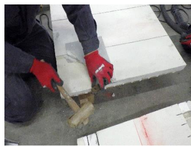
c) 漆喰・ボード界面に皮スキを差し込んでこじって剥がす
