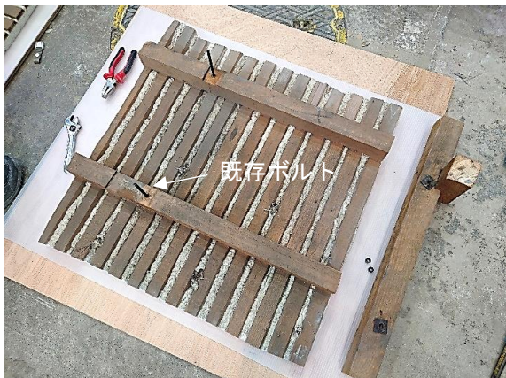
a) 既存野縁受けの取り外し (AMS-2) (既存ボルト頭が野縁裏側にあり撤去不可のため存置)
