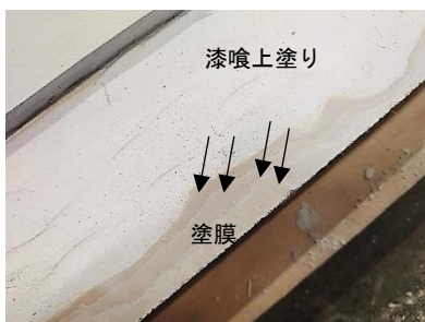
g) 旧塗装部研削状況 拡大 塗膜は4層程度確認
