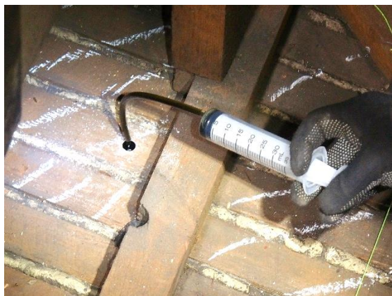
a) 注射器での樹脂注入
