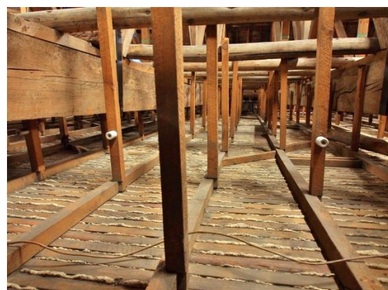
D: 天井部材の基本的な構造 2
