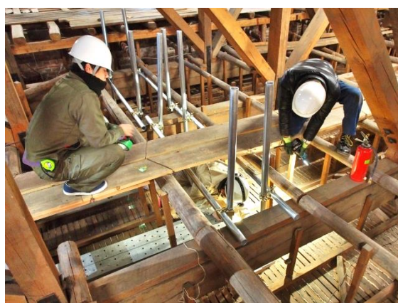
a) 既存の床板の下に潜り込ませて設置 (この場合、施工は伏せた体勢で行う)
