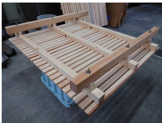
c) 組みあがった下地部分（野縁受けは仮材、こののち外周に側枠を設置）
