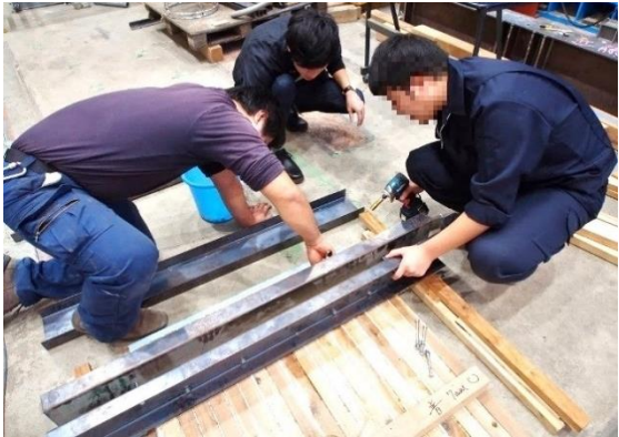
a) 溝形鋼材の野縁への取り付け
