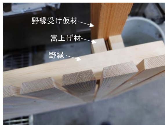
d) 木摺り下地のテーパーと嵩上げされた状態の野縁受け
