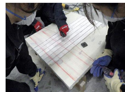
j) 目透かしの芯と合致するようにアタッチメント装着位置を墨付け
