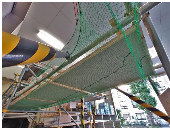
a) 試験体の養生状態（落下防止ネット設置）
