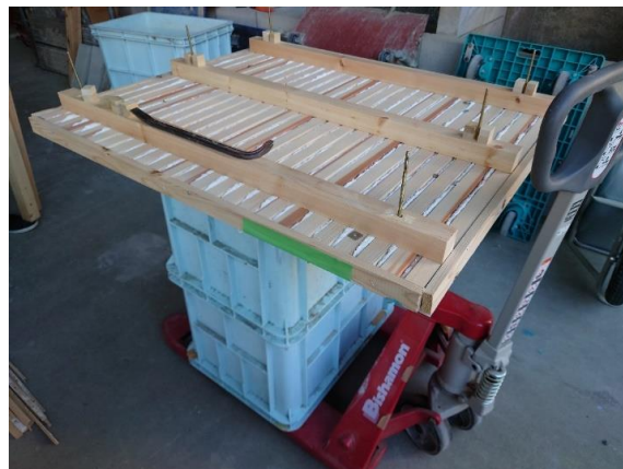
b) ハンドフォークを用いて足場から取り外し、野縁受け仮材撤去状態
