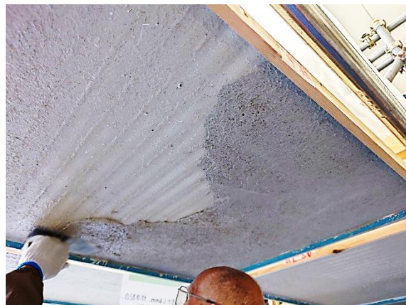
d) 下塗り水引き後の大斑直しの施工 (下塗りの不陸を埋めるように施工)
