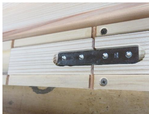
b) 小幅板長さ方向の連結部
