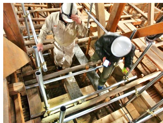
c) 複数の足場を使って拡張した例 (ここでは鋼製足場板を拡張用として用いている)
