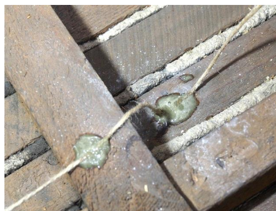
b) パテ充填後（野縁上の麻紐も固着）
