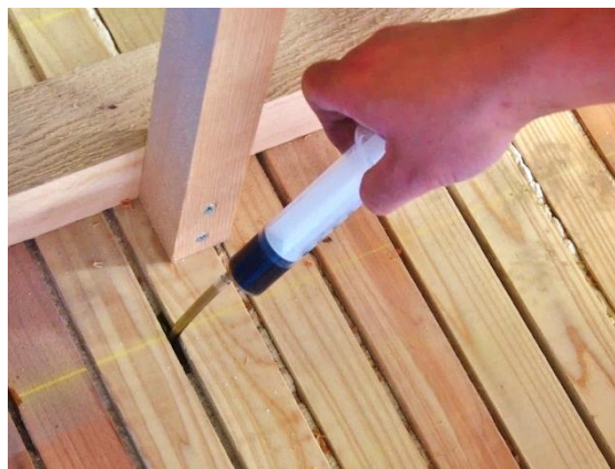
d) 目透かし部への樹脂注入
