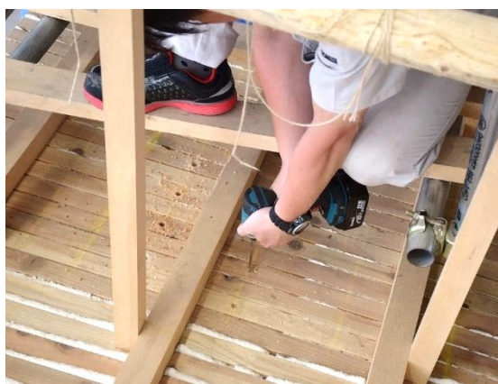
b) 架設した吊り足場上での穿孔作業
