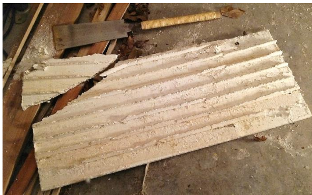
c) 落下の衝撃で一部破損した剥落片
