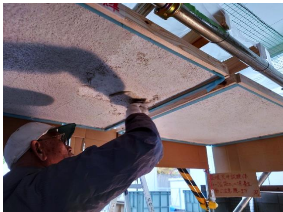
e) 鹿子摺の施工 (不陸調整)
