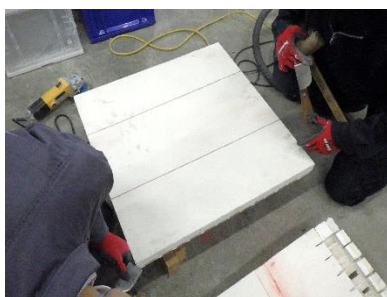
b) ボード厚み分の深さにスリットを入れ、ボードを分割する
