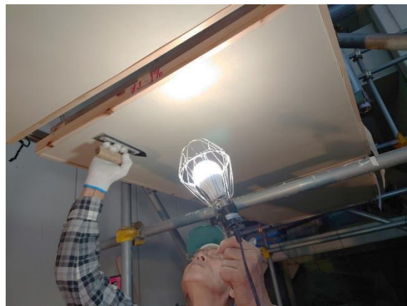
f) 上塗りの施工 (平滑度確認中)
