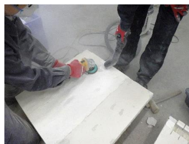
f) アタッチメント装着予定部分の旧塗装膜を研削し、上塗り下を露出させる
