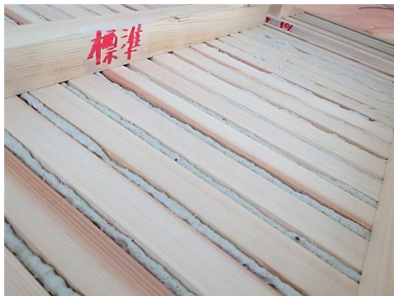
c) 漆喰食い込み状態 (AMS-4 と同水準の食い込み状態と判断した)
