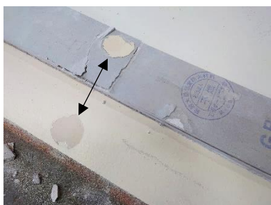
d) ボードの接着剤塗布部の状態 旧塗装の界面で剥離
