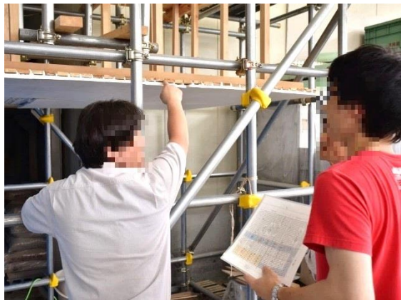
a) 漆喰浮き状態・補修箇所の確認
