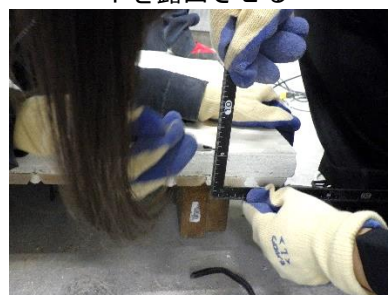
i) 目透かしの芯の位置を漆喰表面へ墨付け
