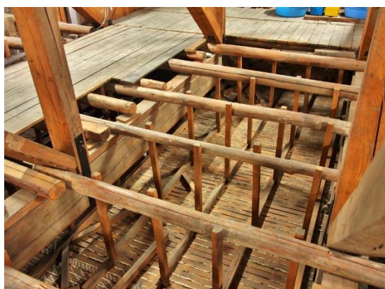
C: 天井部材の基本的な構造 1
