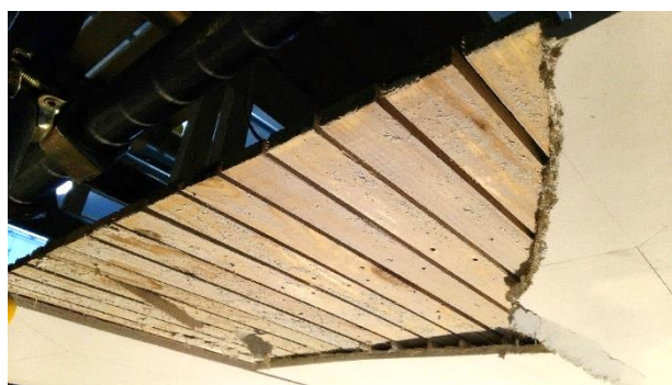
b) 剥落した部分の下地の詳細
