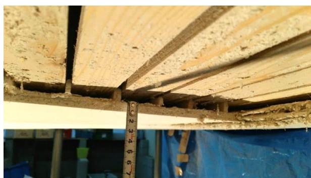
c) 漆喰層が剥離している N2-C との境界部分
