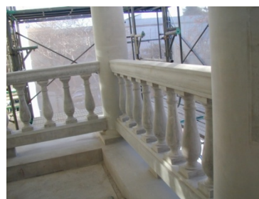
図 4.41 建物に取付けられたトップ&ボトム台座の状態。
