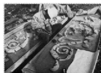
図 6.22 図面化するために裁断されたモルタルレリーフの復元
