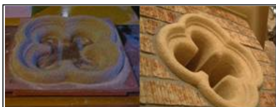
図 5.7 大隈講堂の人造石(小形)据付 左図は取付け前で、右図は取付け後である。
