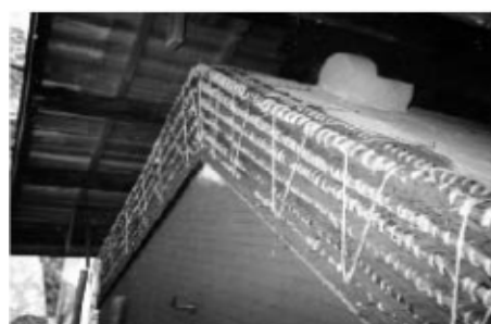
図 2.136 鉢巻き部の小舞・荒壁工法
