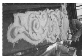
図 6.19 シリコン型取り作業
