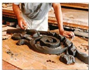
図 6.20 図面に合わせ製作所でモルタル塗りによる復元作業
