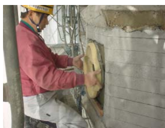
図 6.43 洗い出し仕上げの取り付け
