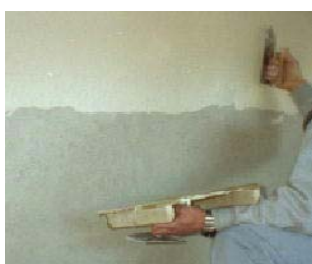
図2.128 漆喰の塗り付け
