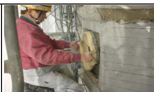
図 5.8 取付け作業 図 5.8 は「大正12年左官仕様書」にある「もるたる洗出」構法でなく「人造石壁面貼附」構法である。
