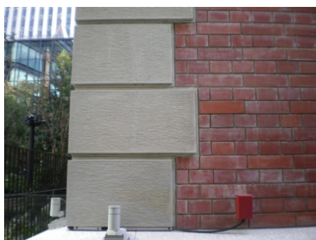
図 6.12 三菱一号館 コーナーストーン風仕上げ（擬石塗りモルタル刷毛引き仕上げ）
