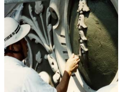
図 6.31 レリーフの張り付けと塗り込み。
