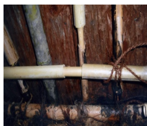
図 2.140 鞘継ぎの屋根裏面
