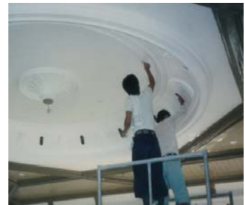
図 6.99 継ぎ目補修
