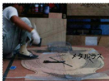
図 6.23 原寸を複写してメタルラスを張る。
