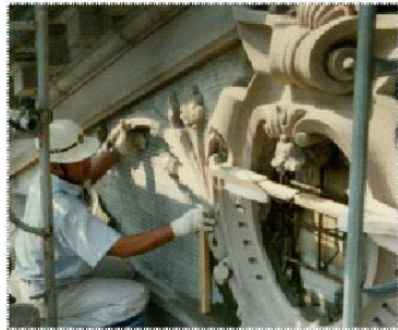
図 6.29 中心オーナメントの取付け位置の確定
