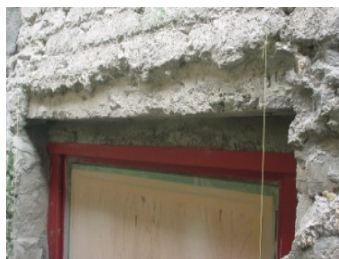
図 6.40 改修工事に伴うハツリ状態
