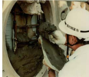
図 6.30 壁面に結合された鉄筋を使用して筋結筋でオーナメントを接合させる。
