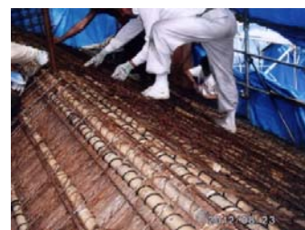
図 2.141 土居葺き作業
