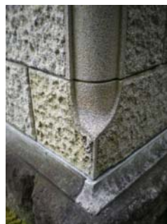
図 6.34 現鳩山会館の几帳面仕上げによるコーナ部分の掻き落とし祖面仕上げ。設計 岡田信一郎 大正 13 (1924) 年
