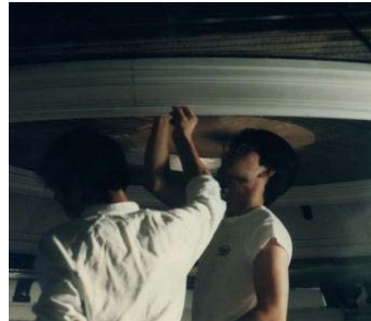
図 6.98 ビス・引き金物で、慎重に躯体に取付けする。
