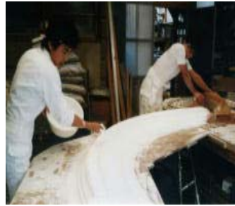
図 6.95 引き型に合わせて石膏をかぶせる。引き型を形状が良くなるまで引き通す。
