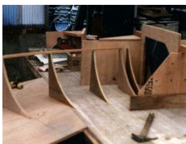
図 6.91 合板で下地引きの型を作る
