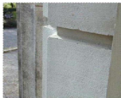
図 6.16 その 2 旧内閣文庫の目地部の擬石仕上げ
