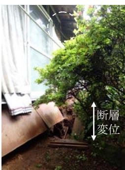
写真8 写真7の住宅と断層変位
