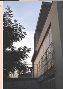
▲ 南側外観(新築当時): 冬の太陽 ▶ 熱を最大限に取り込む計画。 夜は断熱雨戸で保温
