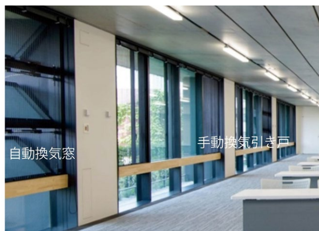
図 2.17 自動換気窓と手動換気引き戸
