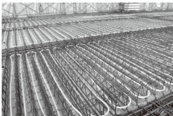
図 1.13 近本らによる事例の埋設配管 21)
