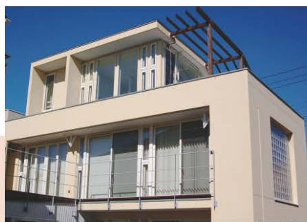
▲ 南側外観(新築当時): 冬の太陽 ▶ 熱を最大限に取り込む計画。 夜は断熱雨戸で保温
